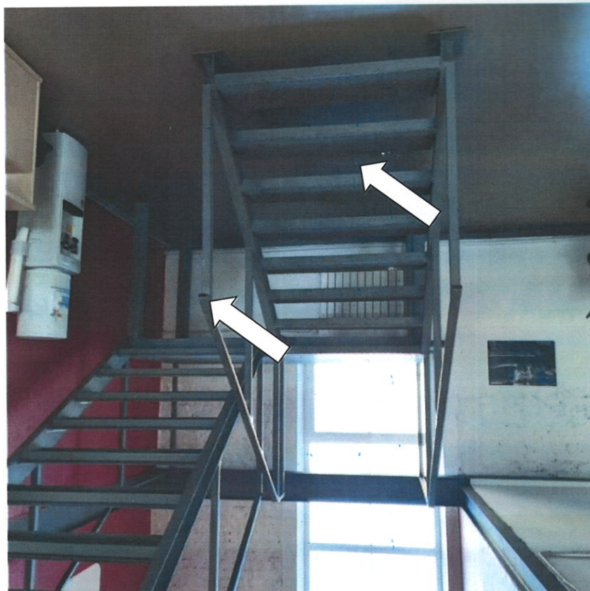
Фото № 6. Нет подступенка. Поручни с травмирующим завершением
